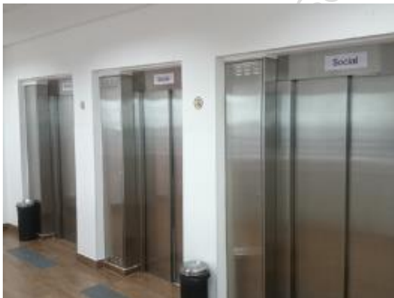
Hall dos elevadores
