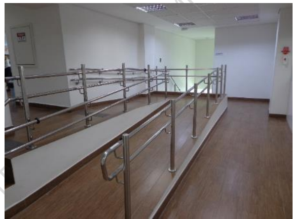
Rampa de acessibilidade
