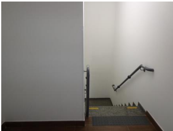
Escada de emergência
